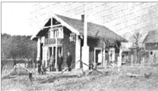
Hovedbygningen på Herøya før ombygningen.
