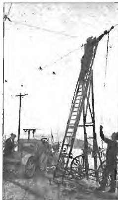
Utbedring av ledningsfeil, omlag 1919. Farlig arbeid!
