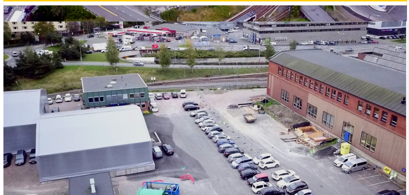
LAGERTELT, PARKERING OG RIGGOMERODE FOR LAKKBOKS
