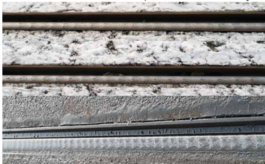
En fin-fin collage av vaskebrett mellom Sinsen og Grefsen, som det ikke var penger til å høvle i år... Dette får vi fordi riflene ikke pusses vekk før de får utvikle seg.
