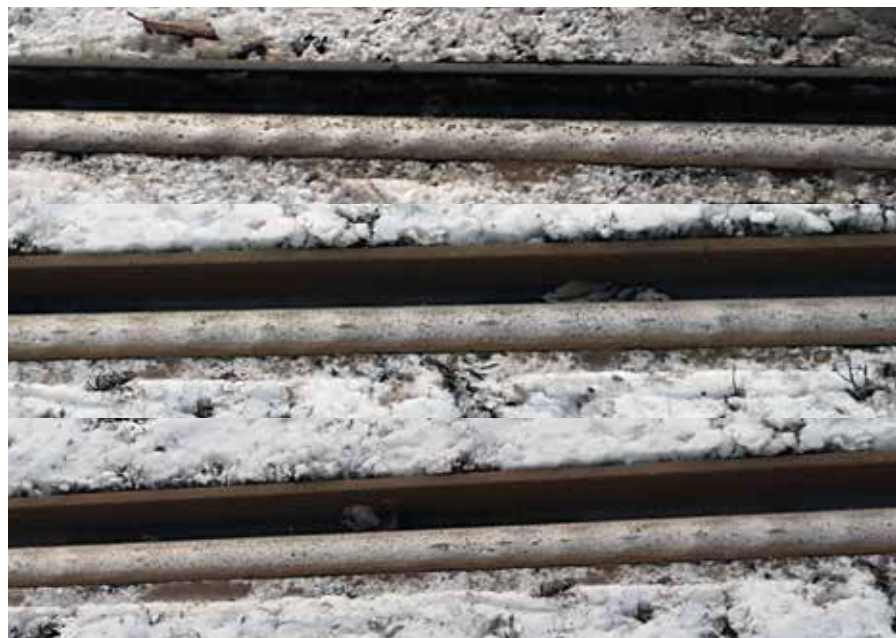
En fin-fin collage av vaskebrett mellom Sinsen og Grefsen, som det ikke var penger til å høvle i år... Dette får vi fordi riflene ikke pusses vekk før de får utvikle seg.
